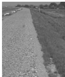
防災ステーションの工事進行中
