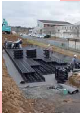
地下貯留槽(調整池)工事中
