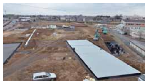
地下貯留槽(調整池)工事中
