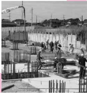
新庁舎の基礎となるコンクリート打設、型枠、配筋工事を行っています。
