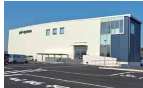
操業開始したパルシステムの板倉食品加工センター
