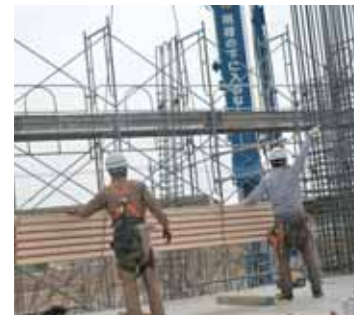
庁舎建設工事の様子
