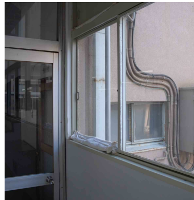
↑ 窓枠の歪による雨漏り
