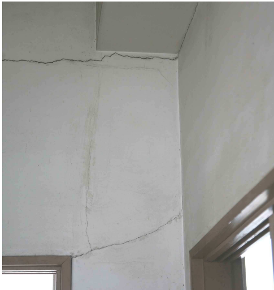
← 内壁クラック
