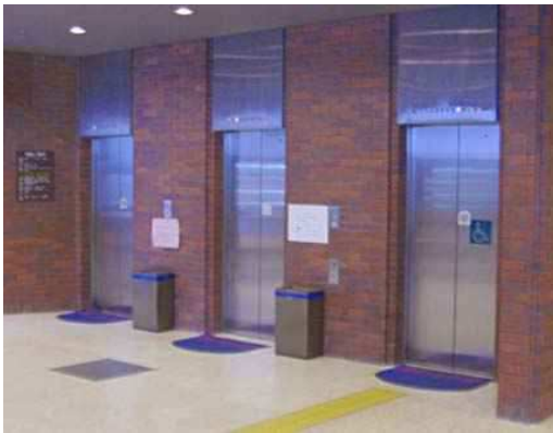
↑ 車いす対応エレベーター
