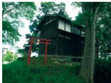
敷地内の小高い部分に建てられている水塚
