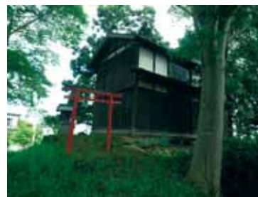
敷地内の小高い部分に建てられている水塚
