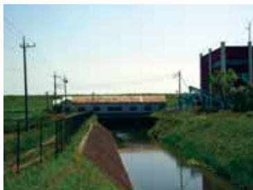
現在も稼働する谷田川第二排水機場
