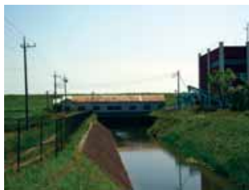
現在も稼働する谷田川第二排水機場
