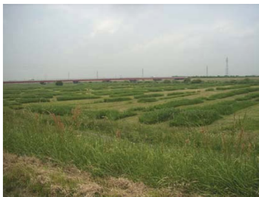
写真 2-2-9 堤防より東北自動車道 渡良瀬川橋を望む
