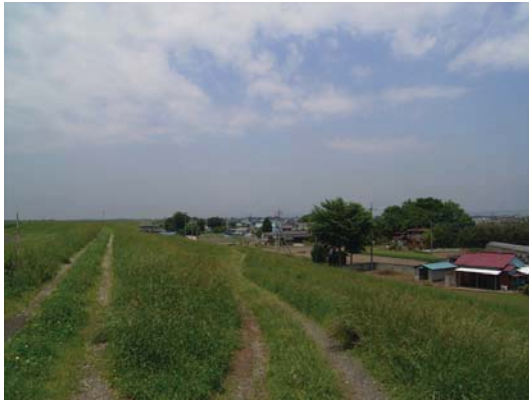
写真 2-2-5 堤防上から隣接する島・大久保集落
