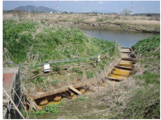
写真 2-2-12 頭沼揚水機場
