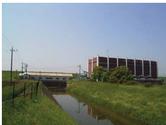
写真 2-2-1 谷田川第二排水機場（左） ・ 国交省谷田川排水機場（右）
