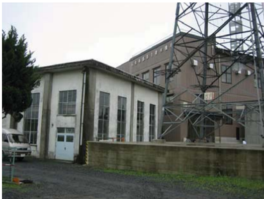
写真 2-2-19 邑楽東部第1排水機場 (前方：旧排水機場・後方：新排水機場)
