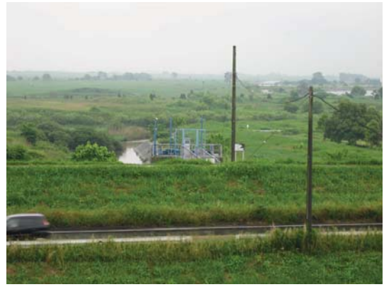
写真 2-2-18 渡良瀬遊水地への排水樋門 (板倉川排水樋管)
