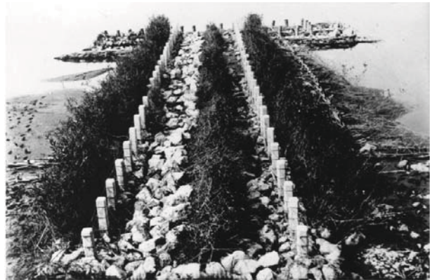
写真 1-2-8 水制のための棒と石だし
