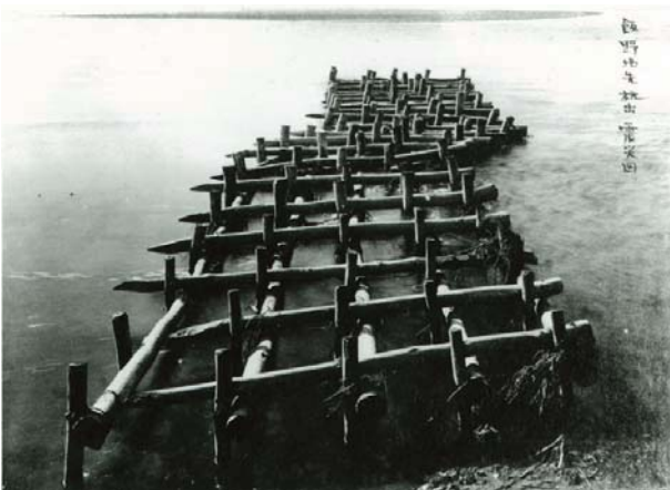
写真 1-2-11 飯野地先杭出 震災図 (利根川上流河川事務所蔵)
