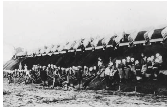
写真 1-2-3 土端打ち作業風景 (西岡地先、大正～昭和初期)
