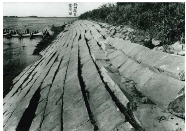
写真 1-2-12 飯野護岸 震災図 (関東大震災時) (利根川上流河川事務所蔵)
