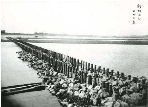
写真 1-2-9 飯野水制 杭打上置 大箇野村飯野地点 大正 12 (1923) 年 11 月 15 日 (利根川上流河川事務所蔵)
