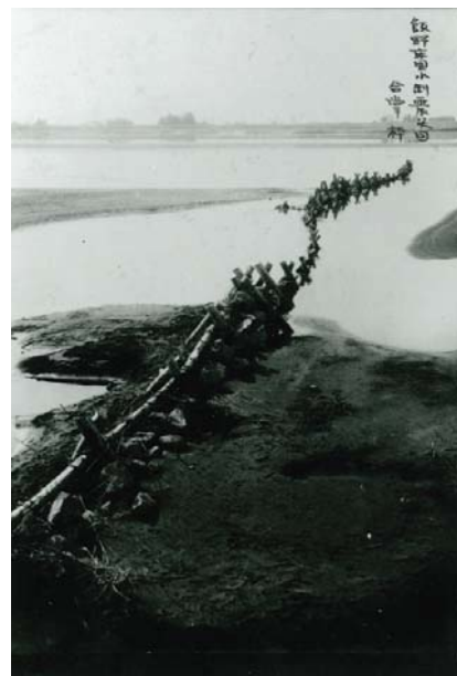
写真 1-2-10 飯野床固水制震災図 合掌杵 破損した水制、流出物が引っかかっている。 (利根川上流河川事務所蔵)
