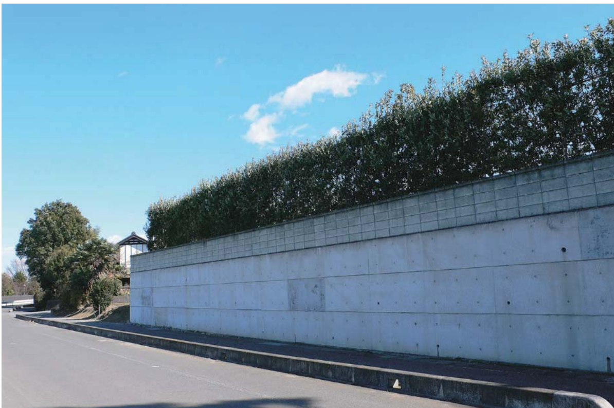
写真1-2-18 敷地の北西側に連続していた水塚と屋敷林が途中で切られ、コンクリートとブロックの高く直立したよう壁で悪化した景観（海老瀬地区新田集落）
