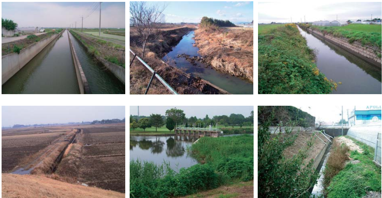
写真 2-1-3 用排水路の状況
