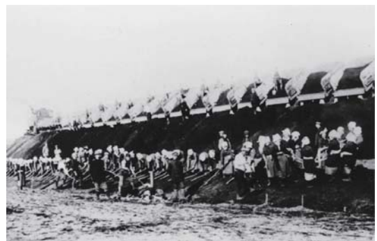
写真 2-2-3 土端打ち作業風景 (西岡地先、大正～昭和初期)
