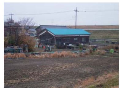
写真 3-3-54 大箇野排水機場 大箇野排水幹線水路から渡良瀬遊水地側に排水を行った。昭和 29（1954）年に設置され、現在は稼動していない。
