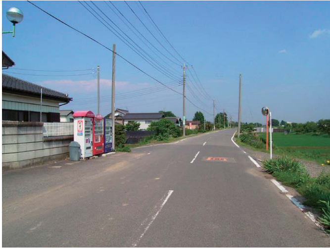
写真 3-2-54 古利根堤防道路
