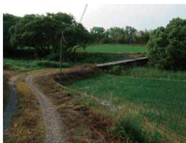
写真 3-2-52 沈下橋（北坪東橋）
