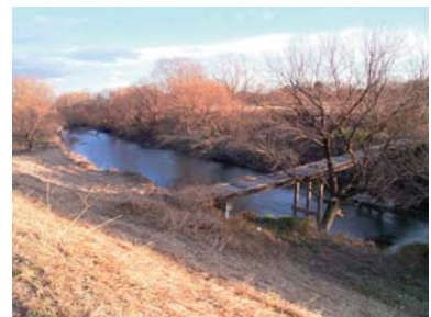
写真 3-3-50 沈下橋（通前橋）
