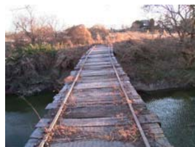
写真 3-2-44 沈下橋（通前橋）
