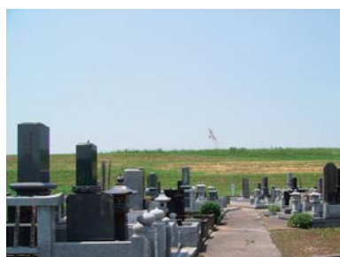
写真 3-2-66 ランドマークとなる利根川堤防
