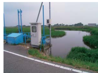
写真 3-3-15 鶴生田川第一樋門
