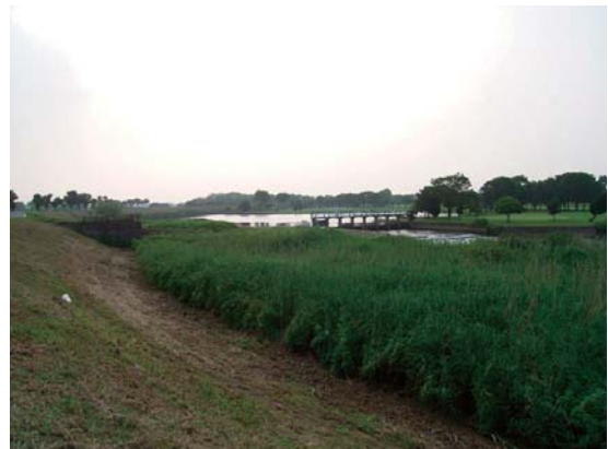
写真 3-3-32 八間樋頭首工の周辺状況 ゴルフ場の南側に八間樋頭首工が設置されている。八 間樋の上流側では北根用水路(旧高鳥用水路)が取水さ れている。
