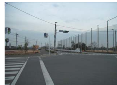
写真 3-3-36 ゴルフ場北端部の状況
