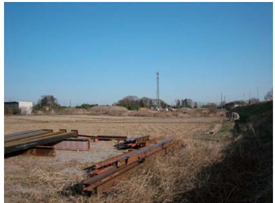
写真 3-3-2 小保呂地先の現況 写真 3-3-1 とほぼ同じ場所を写す
