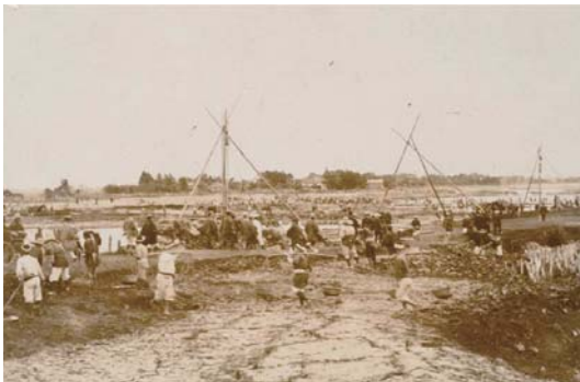
写真 3-3-1 谷田川堤防決壊工事 小保呂地先における明治43年の工事
