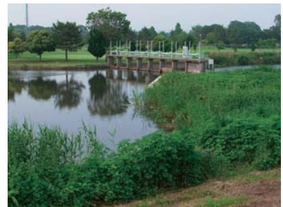
写真 3-3-35 八間樋堰周辺
