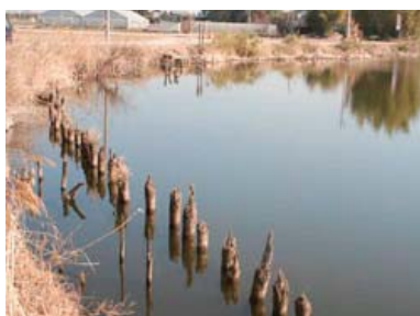
写真 3-2-31 堤防の土留めの杭（行人沼）
