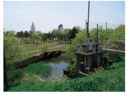
写真 3-3-34 小保呂排水機場樋門周辺
