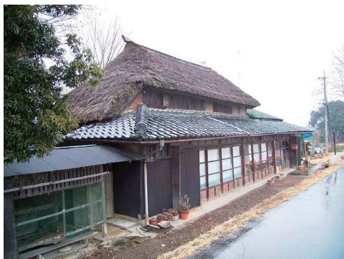
写真 3-2-38 堤防道路（古河往還）沿いの茅葺屋根の民家
