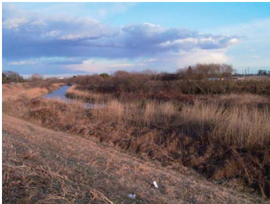
写真 3-3-43 左岸堤防から下流側の景（冬季） 堤帯間の幅が狭いことから、河川としての一体感が感じられる。
