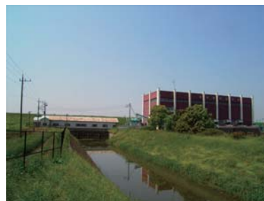
写真 3-3-14 谷田川第 2 排水機場（左）
