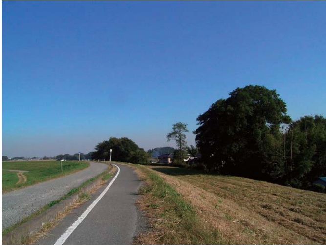
写真 3-2-1 渡良瀬川堤防
