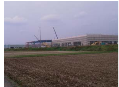
写真 3-3-13 岩田流通団地（建設中）
