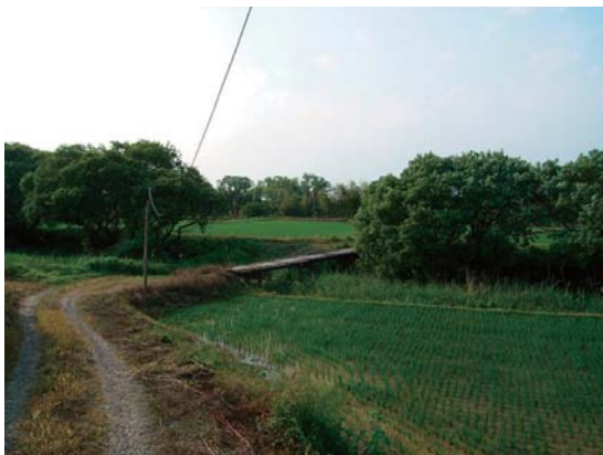
写真 3-3-45 河道内に形成された水田の景（冬季） 旧合の川との合流部には、かつての中洲に水田が形成され、廃川となった流路や中洲に至るための沈下橋が見られる。
