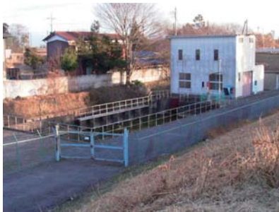
写真 3-3-37 小保呂排水機場
