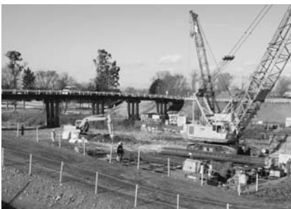
▲完成が待ち遠しい八間樋橋 現在、橋脚工事が進行中
