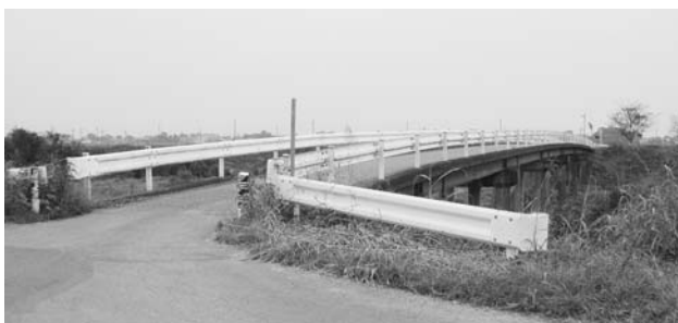
▲かけかえが待たれる八間樋橋
