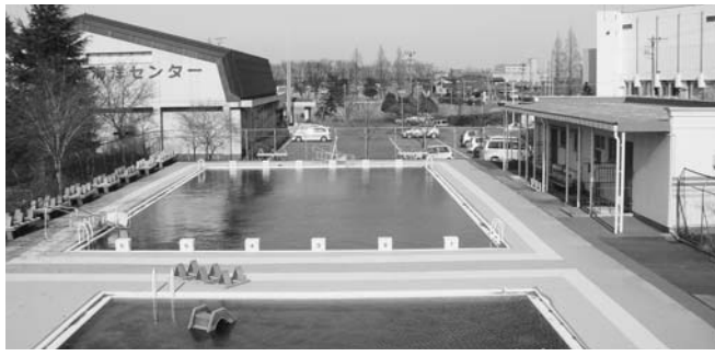
▲屋根が撤去された海洋センタープール
