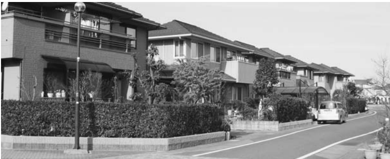
▲LPガス集中供給方式のニュータウン住宅地
