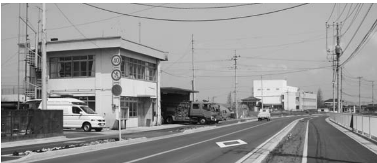
▲平成20年には新設移転が予定されている消防板倉分署
