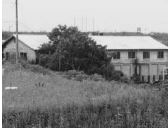
▲改修が予定されている谷田川第一排水機場
