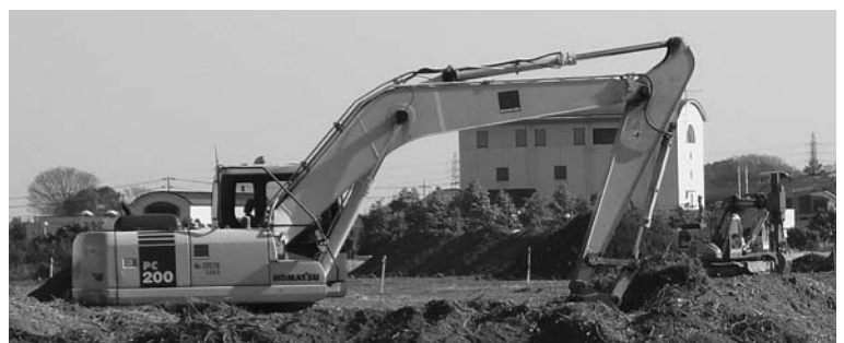
▲企業誘致促進に向けて造成工事が急ピッチで進む
