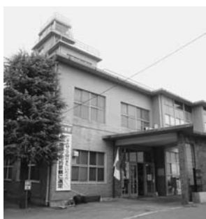
▲ S33年に建てられた本庁舎
