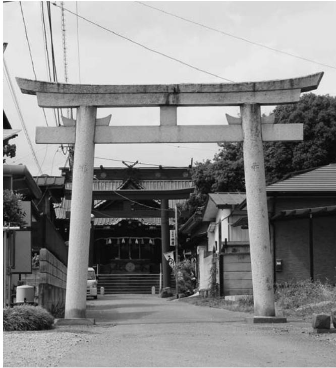
▲今年度から道路工事が予定されている雷電神社参道
