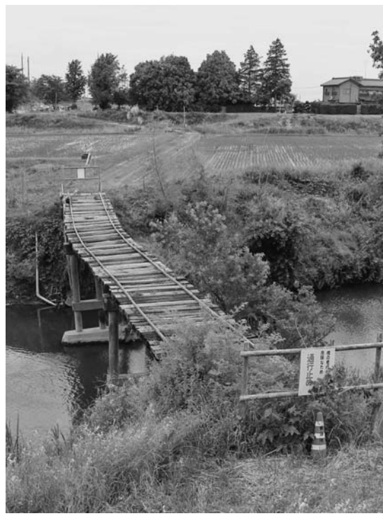
▲橋脚が傾き通行止めとなっている沈下橋
