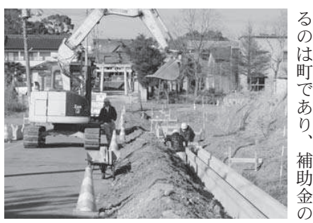
▲2期工事が進む雷電神社参道
