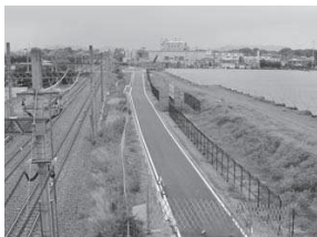
▲7月末完成となる町道の様子
