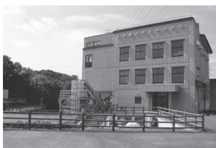
▲板倉川の下流にある邑楽東部第1排水機場
