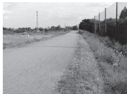
▲除草管理が行われた谷田川堤防
