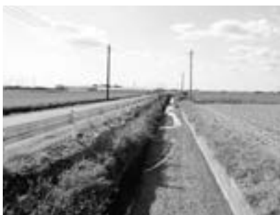
29号水路（大字大荷場）
