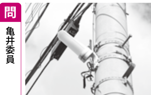
町内に設置されている標準的な防犯灯
