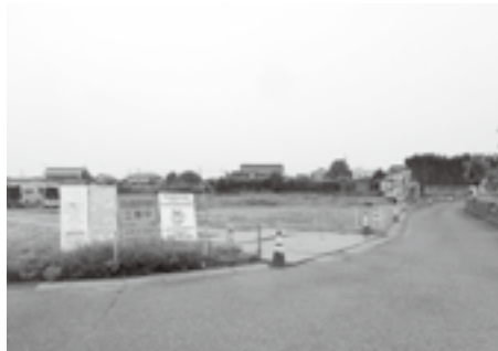
洪水時緊急避難場所（海老瀬地区）周辺（工事中）
