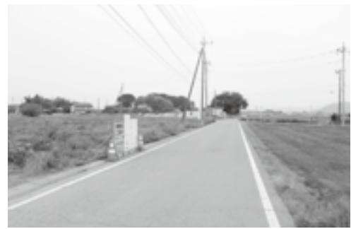
洪水時緊急避難場所（西岡地区）周辺（工事中）
