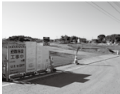
西岡地区 緊急避難場所（工事中）
