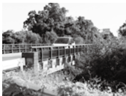
板倉町側から見た合の川橋
