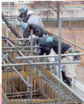
新庁舎建物1階部分の鉄筋、型枠、コンクリート工事を行っています。
