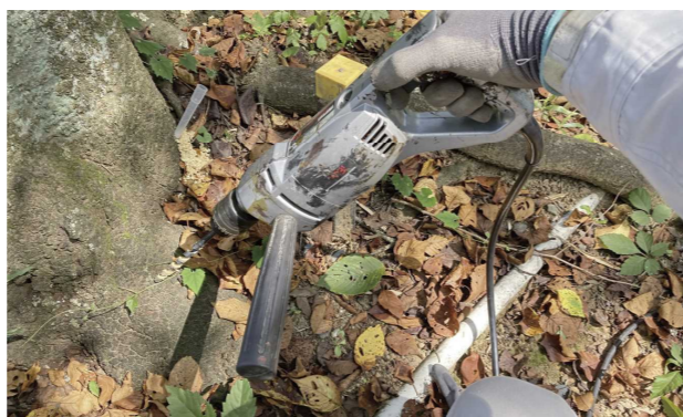
地際部（根と土の間）にドリルで穴を開ける
