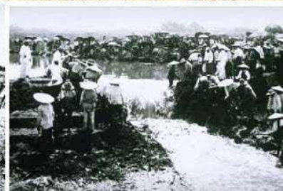
藤岡地先開削部の通水
