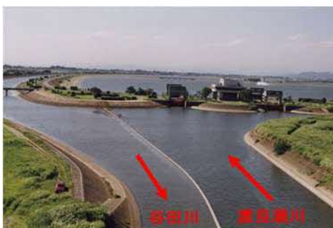
谷田川分離施設
