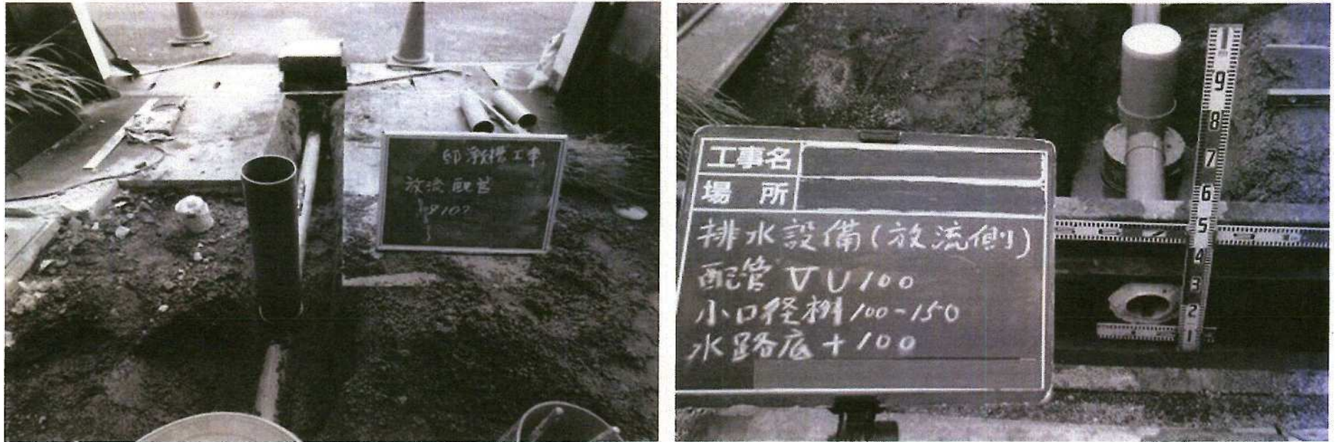
写真(放流先接続状況)
