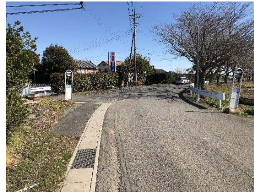
⑦小池鉄工付近
