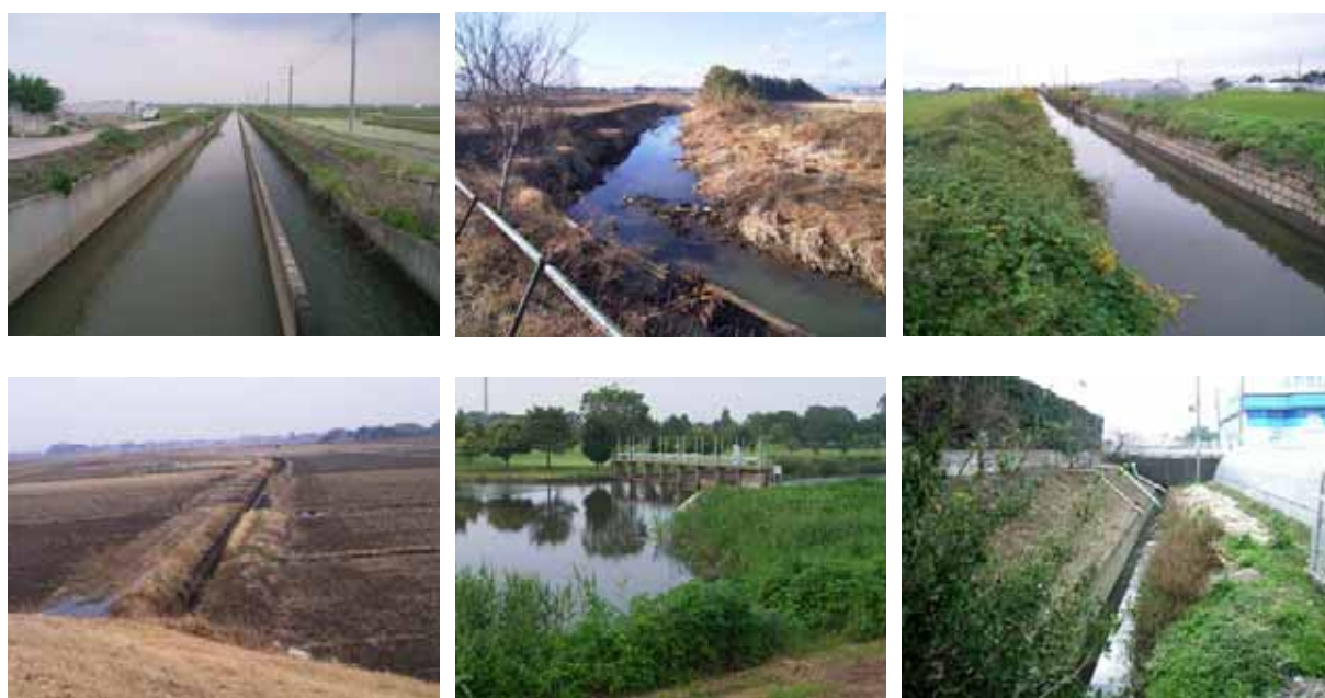
写真 1-1-3 用排水路の状況
