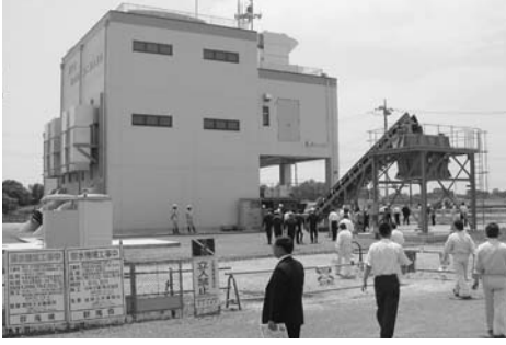
改修工事が完成した邑楽東部第2排水機場
