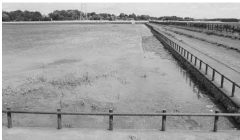
▲農地防災事業の大泉町常光寺遊水池
