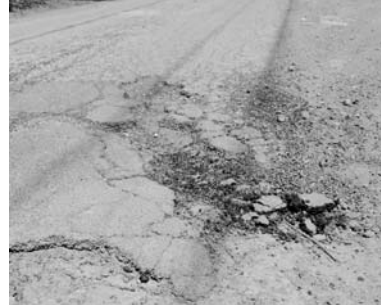
▲老朽化で傷んだ箇所は補修で対応
