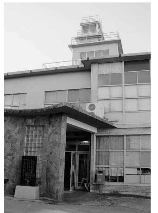
▲老朽化し、防災関係等が耐えられない役場庁舎
