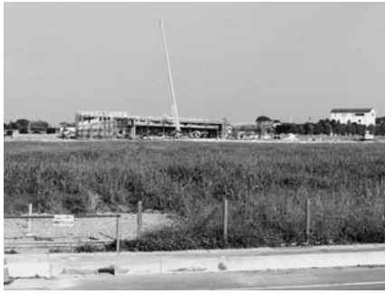
▲工場の建設が進むニュータウン産業用地
