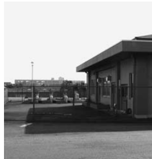
▲表流水を配水する西浄水場
