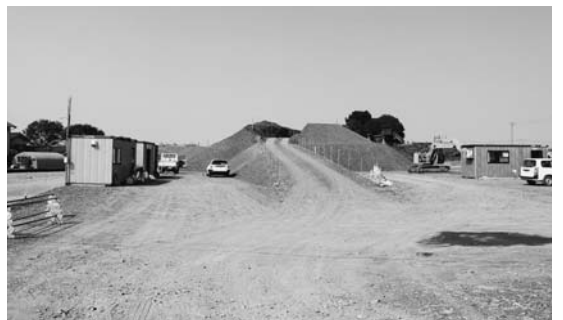
▲下五箇側の国道354号バイパス予定地(谷田川堤防)
