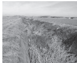
▲掘削によって維持される排水路
