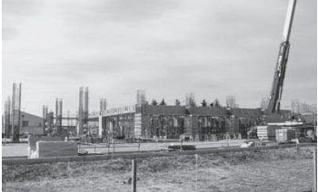
▲役場新庁舎建設工事の様子
