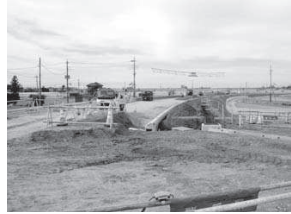
▲順調に工事が進む国道354バイパス
