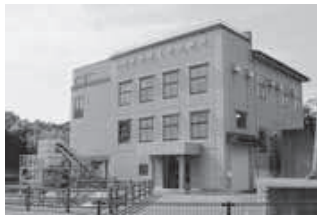
▲邑楽東部第1排水機場の全景
