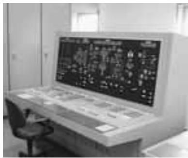
▲落雷により故障したメインパネル
