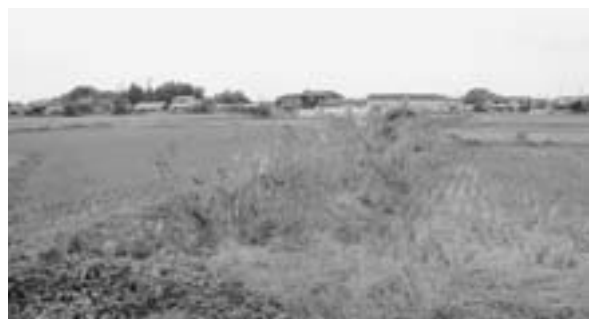
▲大字岩田滑稽地区にある排水路の様子
