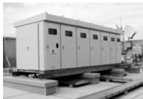
▲役場庁舎屋上に設置されたキュービクル
