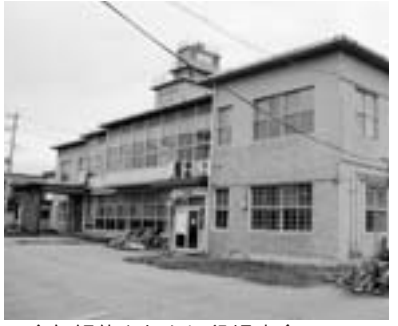
▲今年解体された旧役場庁舎
