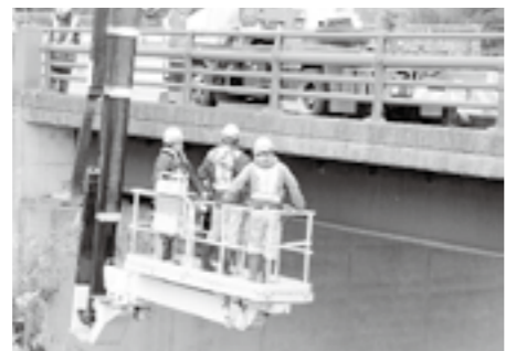
橋梁点検の様子
