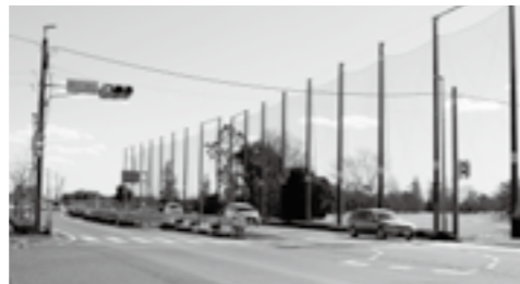
現在はガードレールの一部撤去、右折誘導線、路肩にポストコーン、中央に反射板を設置し、逆走防止のための改善がされました。
