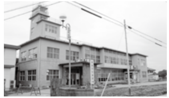
昨年解体された旧役場庁舎
