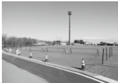
工事が完了した緊急避難場所(海老瀬地区)
