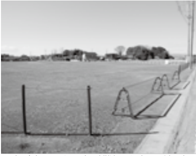
工事が完了した緊急避難場所(西岡地区)
