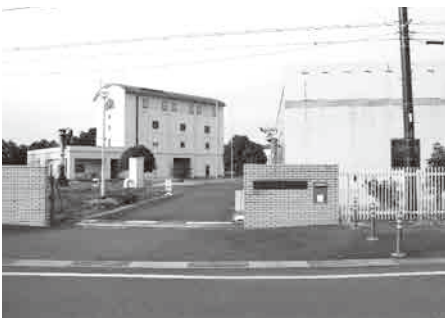
板倉町水質浄化センター
