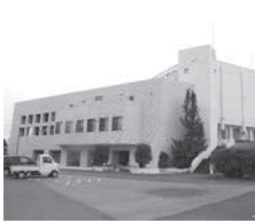
昭和53年に竣工した中央公民館
