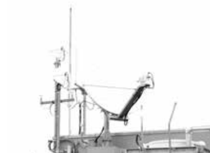
役場屋上のパラボラアンテナ
